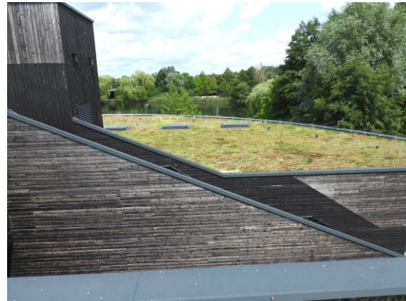
Abb. 2: Ein Teil der unteren Ebene des begrünten Daches mit Blick auf die hölzerne Gebäudefassade im Juni 2023.
